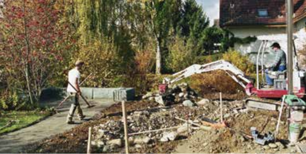
Vorher: Auf dem Baustellenfoto sieht man, wie der Feuchtgraben angelegt wurde.
